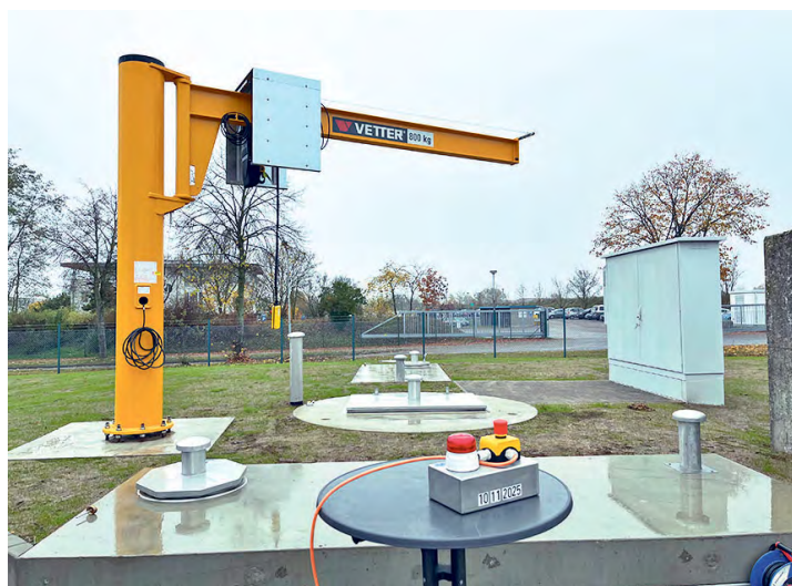
Ein Blick auf das neue Pumpwerk in Heiligengrabe. Dazu gehört auch ein Kran, der die Pumpen – jede wiegt rund 500 Kilogramm – bei Bedarf nach oben ziehen kann.
