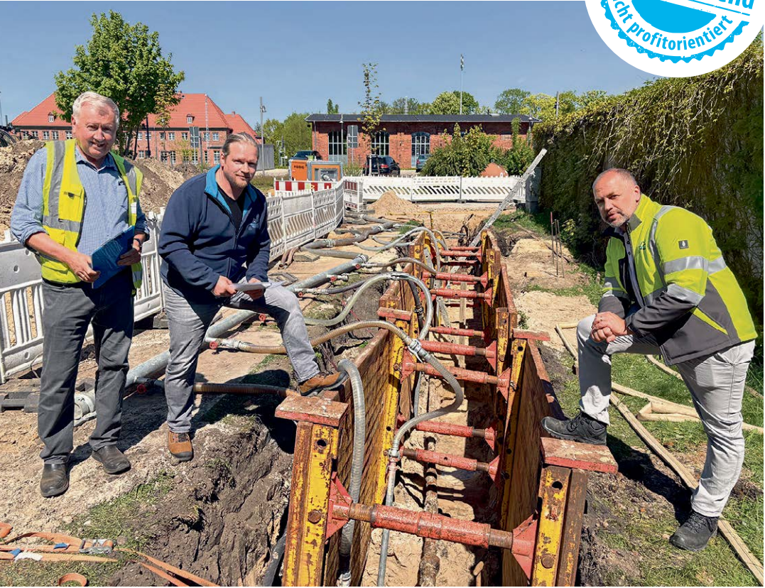
Ein wichtiger Bestandteil jeder Baustelle sind regelmäßige Baurapports. Auch in der Rosenplansiedlung. Hier werden die Schmutzwasserkanäle erneuert. Andy Thierbach (Verbandschef, r.), Guido Ramin (Techniker Abwasser) und Jürgen Hinze vom gleichnamigen Ingenieurbüro (l.) besprechen, ob alles nach Plan verläuft.
